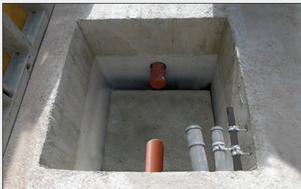
Etter støping: Pumpekummen er lysegrå, den støpte sålen er mørkegrå.
