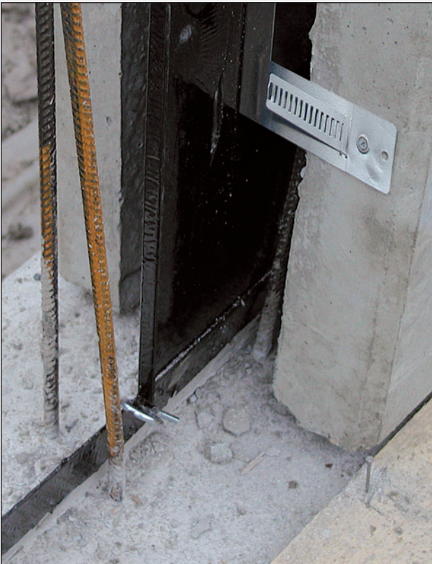
Ved hjelp av de regulerbare laskene kan veggprofilene alltid forbindes med gulvprofilen.
