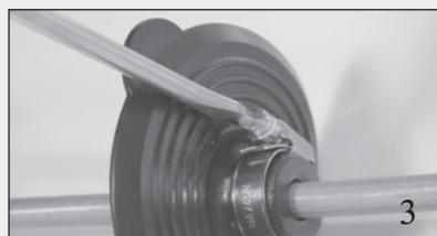
Stram de to båndene av rustfritt stål
