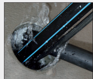
Innsprøyting av Flex 2000
