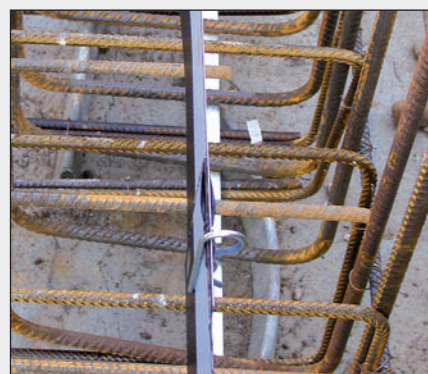
Overlapping og sikring med skjøteklemmer.
