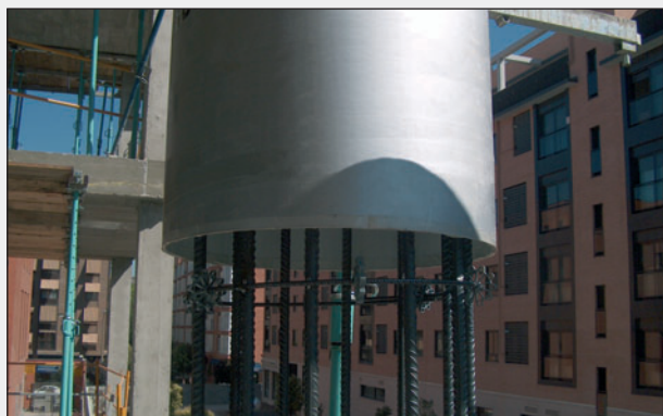
Forskalingsrøret skyves over armeringen.
