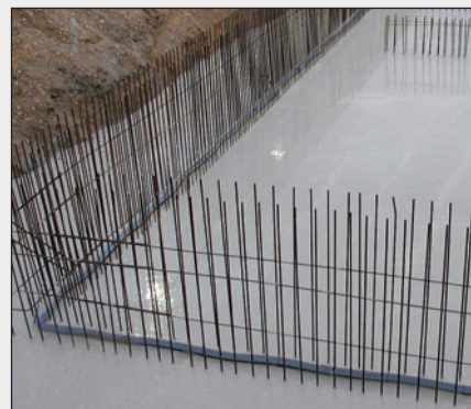
Sikker innfuging i betongen, maksimalt halv platebredde.
