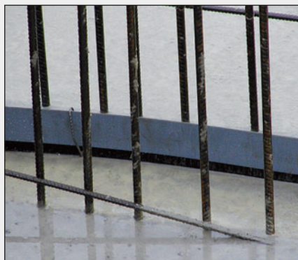
Sikker innfuging i betongen, maksimalt halv platebredde.
