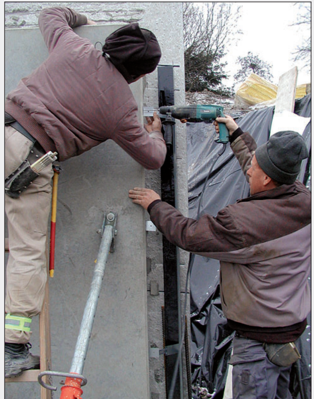
Feste av en hjørneprofil. Laskene er også regulerbare.
