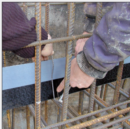
Montering med monteringsklemme på armeringen.
