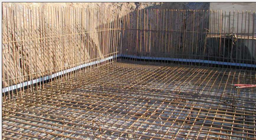
Trekk av det nederste silikonpapiret før støpingen.
