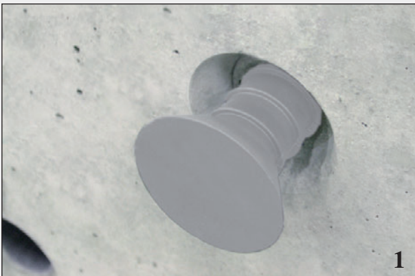
Tetting av en konusåpning
